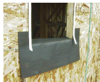
先張り防水シート施工
