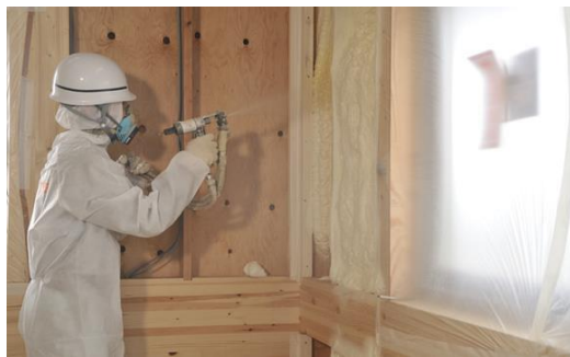
現場発泡吹付断熱を推奨
